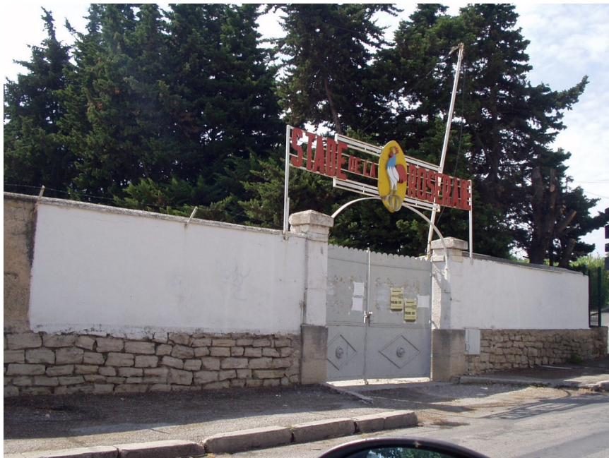
Foto 2 – O pórtico de entrada do estádio Roseiraie em Carpentras antes da restauração. Fonte: Brun, 2004.
