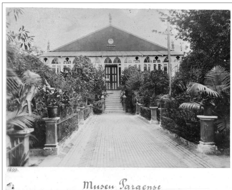
Figura 1: Edifício principal do Museu Paraense, conhecido como Rocinha, em 1899. Fotógrafo não identificado. (Acervo MPEG)
