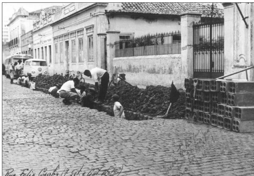
Rua Felix Cunha (9. Set. e Oct. 1955) Abertura de valas para cabos, década de 1950.
