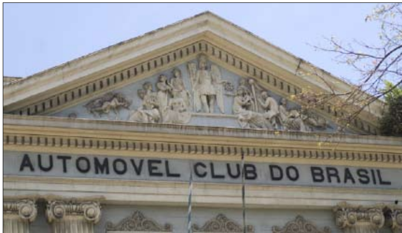
Figura 3 - Detalhe da fachada frontal do prédio do Automóvel Club do Brasil, Rio de Janeiro. Foto - Cesar Duarte / Interativa Fotografia e Comunicação, 2008.
