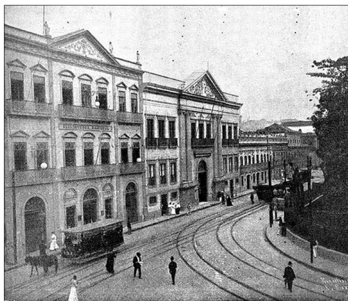
Figura 1 - Fotografia do conjunto arquitetônico que inclui, à direita, o prédio do Automóvel Clube do Brasil. Imagem encontrada no calendário da Leiteria Bol - RJ, 1926.
