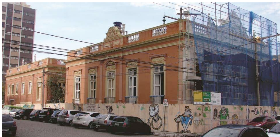
Figura 11 - Fachada atual do prédio do Casarão Barão de Cacequi. Situação atual. Fonte: Acervo Keli C. Scolari, 2012.
