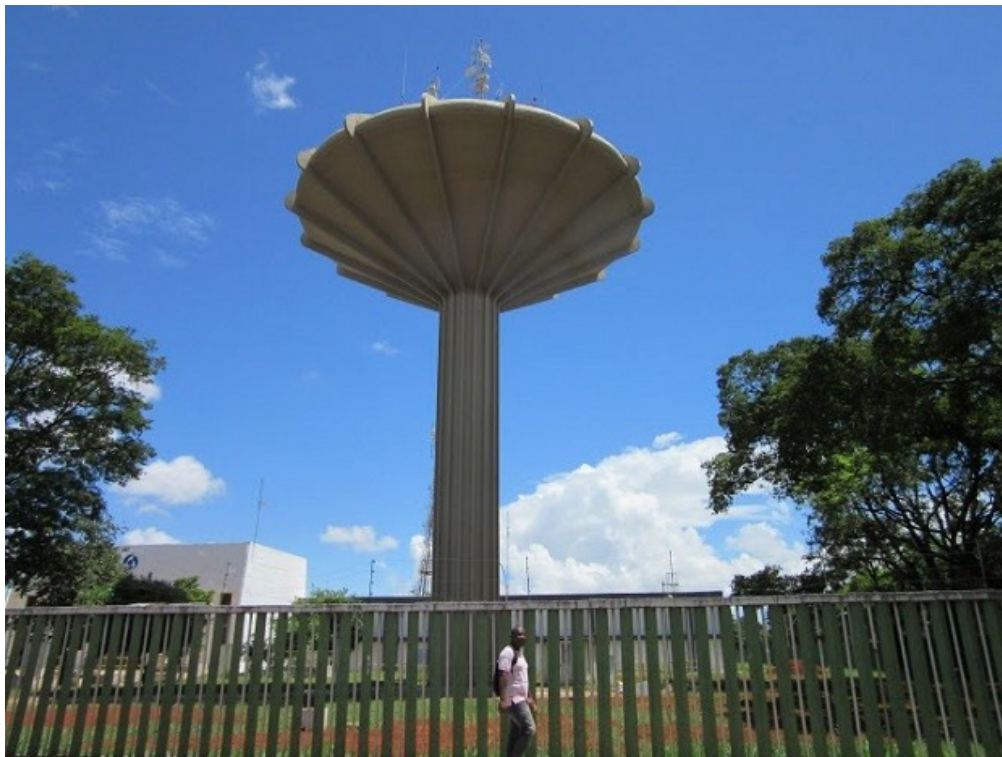
Figura 7- Caixa d'água da Ceilândia, s/d.
