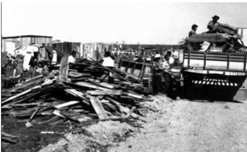
Figura 3 - Remoção de barracos na Vila do IAPI, 1971. Fonte: ArPDF FundoSCS/GDF.
