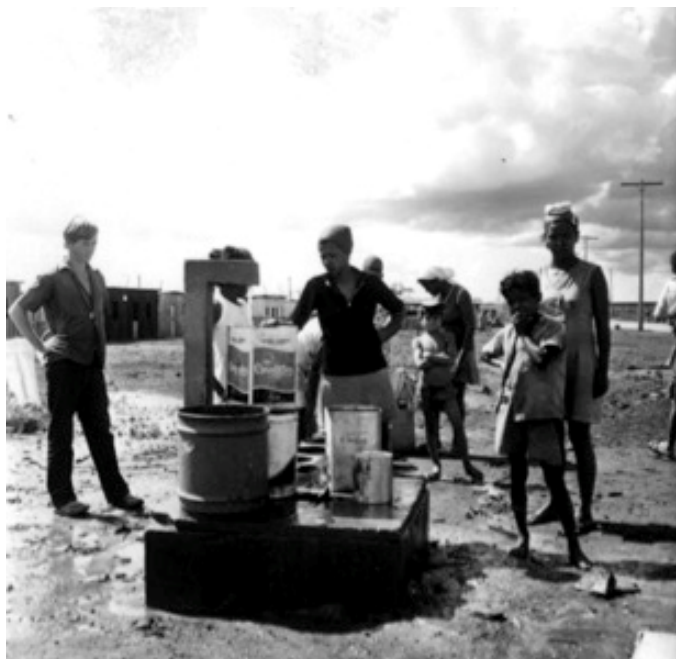
Figura 6 - “Chafariz”- Ceilândia, s/d. Fonte: Arquivo Público do Distrito Federal.
