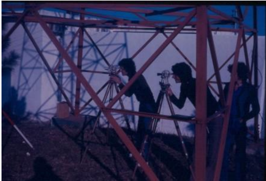
Figura 1 - Aula prática de topografia utilizando os teodolitos Zuiho. Foto: Acervo do museu Ênio Miguel
