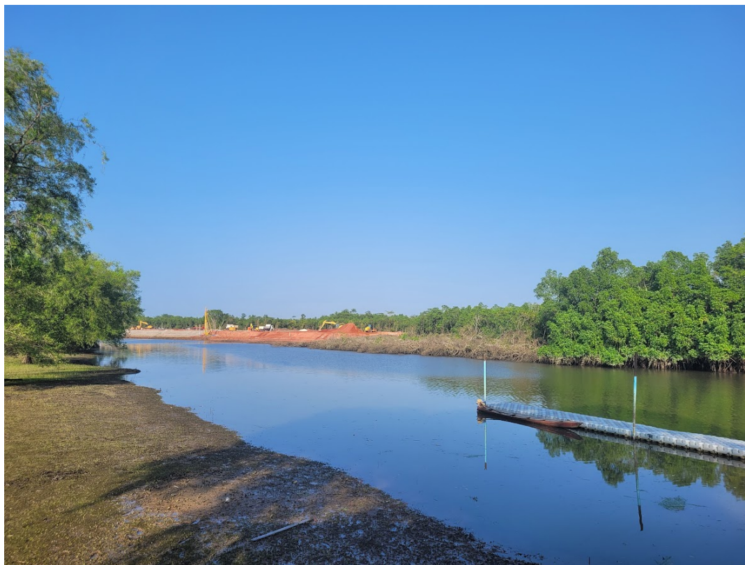
Figura 2- Orla de Ananindeua em construção, setembro de 2023
