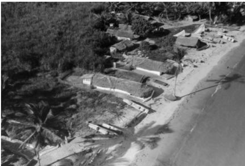
Figura 1 - Casario de taipa e palha na Praia de Suape.
